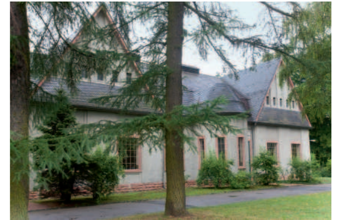
Keine herrschaftliche Villa, sondern die Außenansicht des Wasserwerks Wilhelmsbad
