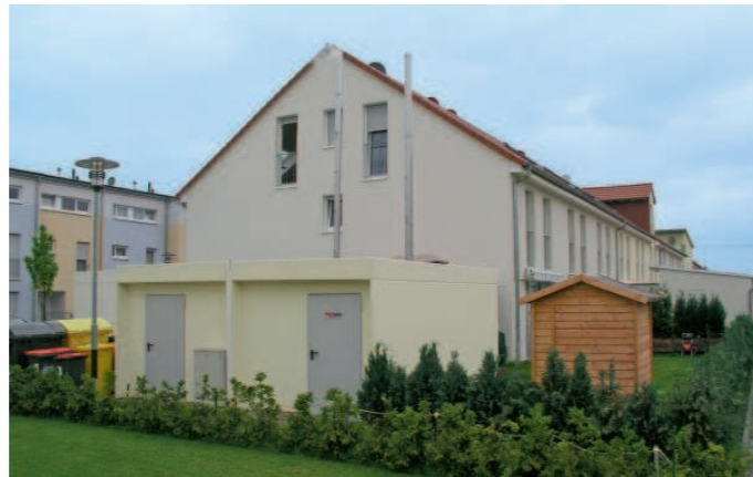
Die Nahwärmezentrale im Neubaugebiet „Am Pachtanger“ ersetzt die Heizung von 34 Häusern
