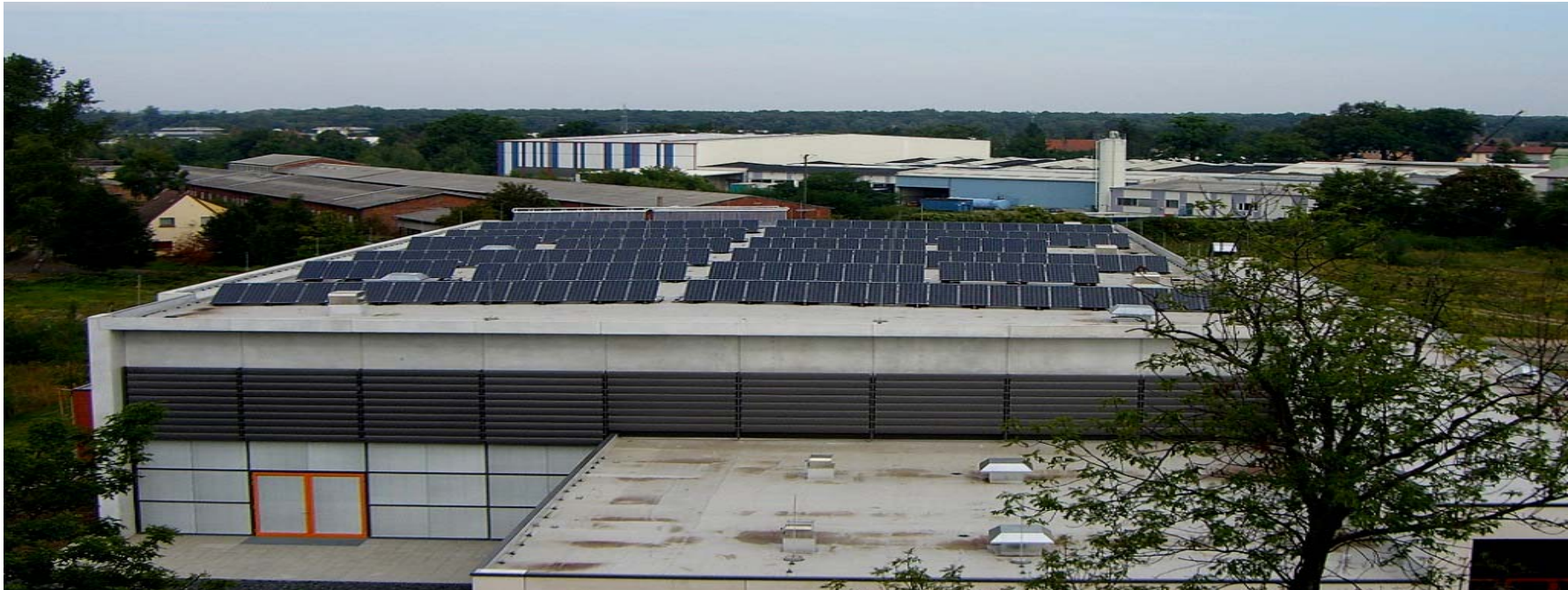
PV Anlage Hessen Homburg 38,5 kW peak : Ertrag kWh/CO 2 Einsparung in kg
