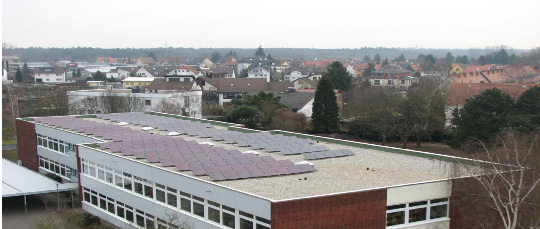
PV Anlage Erich Kästner Schule 25,16 kWpeak: Ertrag in kWh/CO 2 Einsparung in kg
