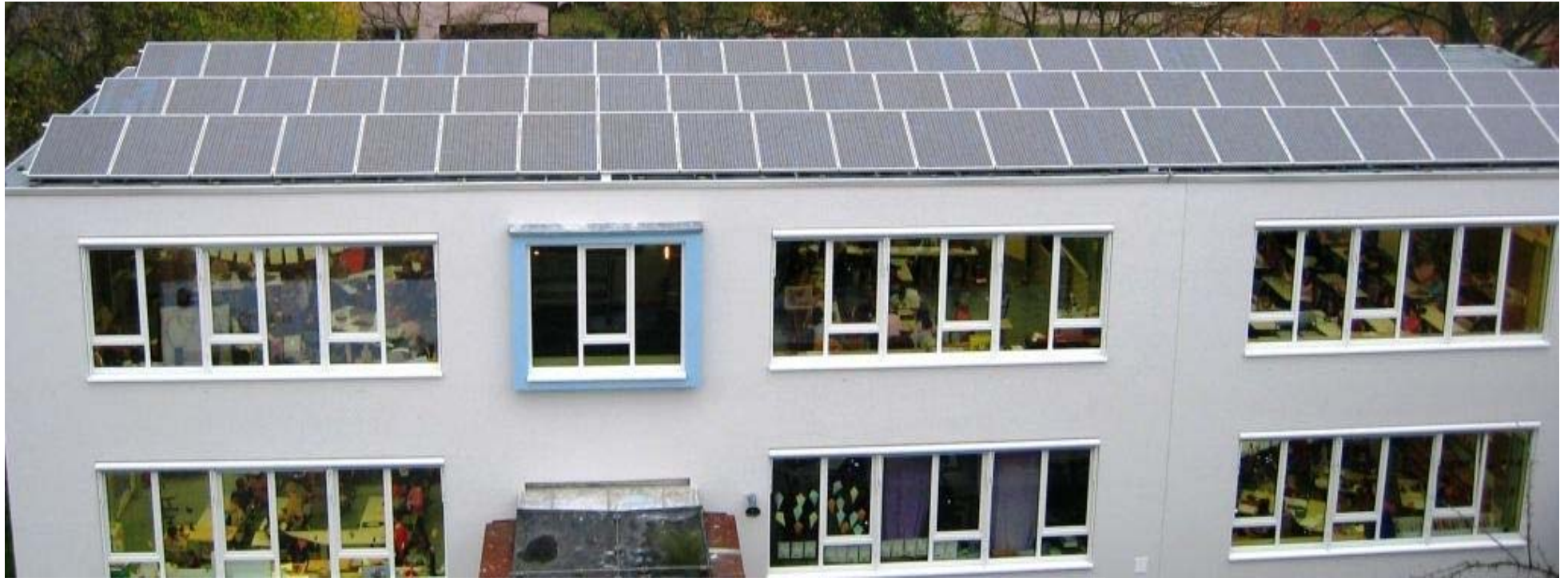
PV Anlage Eichendorfschule 21,84 kW peak : Ertrag kWh/Einsparung CO 2 in kg
